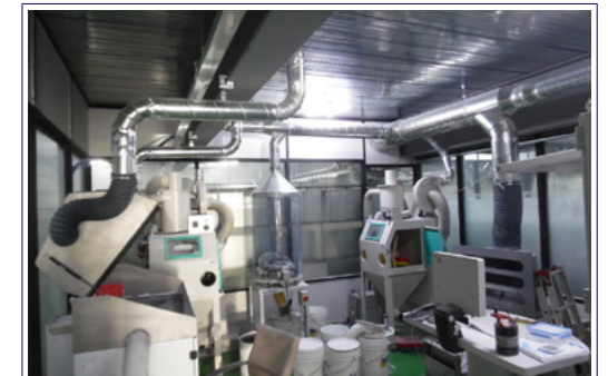
▲ 국소배기장치 및 방지시설 설치
